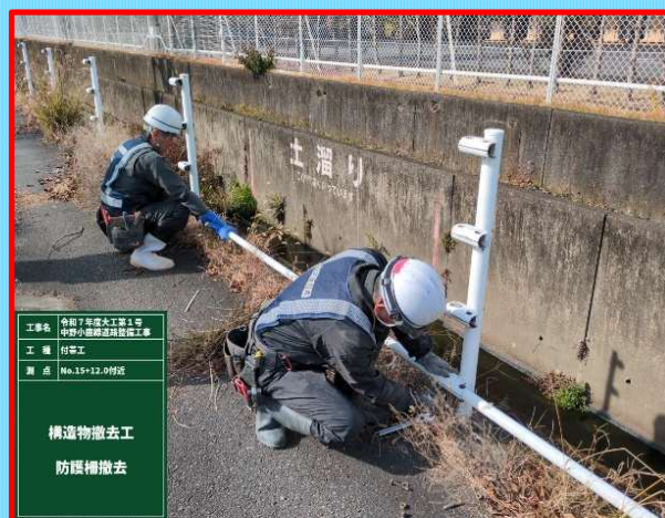
↑転落防止柵撤去
