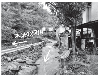
写真－1 油山地区の被害状況
