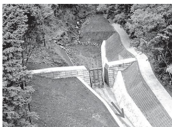
写真－4 完成した砂防堰堤（小沢）
